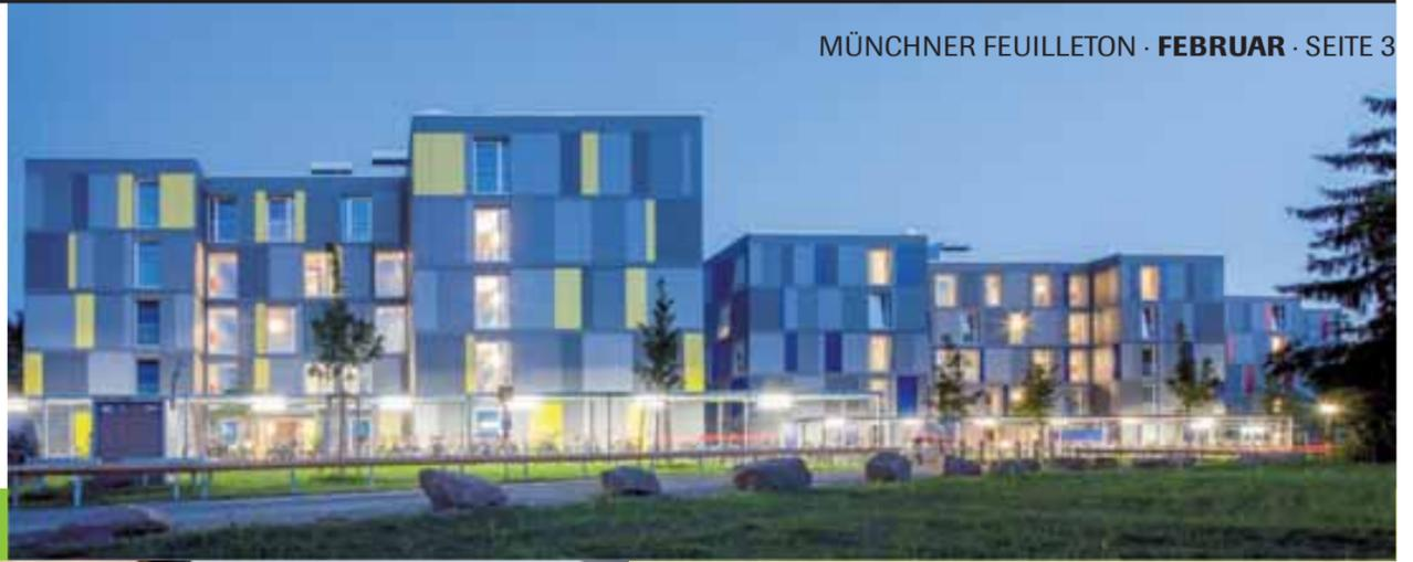
Rechts: Die bezugsfertige Errichtung eines Gebäudes mit ca. 200 Moduleinheiten nimmt in der Regel nicht mehr als vier Monate in Anspruch | © LiWood, Sascha Kletzsch
