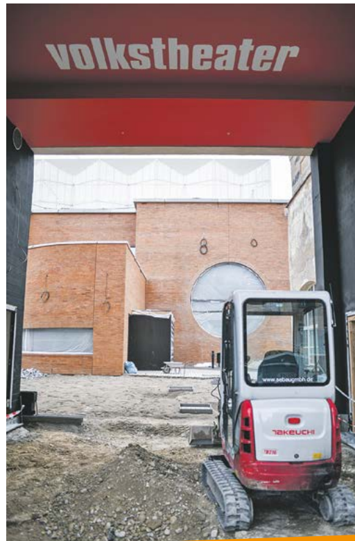
links: Die Fassade des Altbaus, in dem Künstlerwohnungen und Verwaltung untergebracht werden, bleibt so, wie sie war und erzählt ihre eigenen Geschichten. Neu sind die zimmerhohen Fenster und die kunstvoll geknickten Geländer
